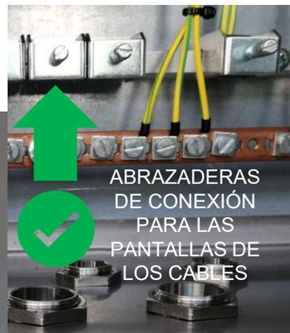
ABRAZADERAS DE CONEXIÓN PARA LAS PANTALLAS DE LOS CABLES
